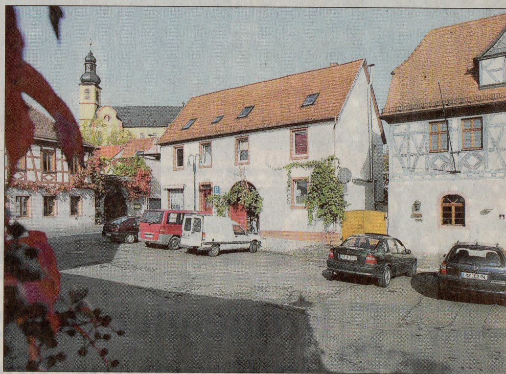
Nach der Umgestaltung des Carl-Zuckmayer-Platzes – Baubeginn soll 2006 sein – bleiben von 14 Parkplätzen nur drei übrig. Neuer Parkraum ist in der Langgasse geplant. Foto: hzb/Jörg Henkel
